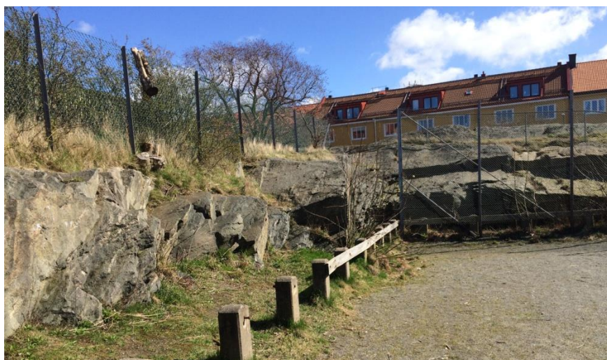
Foto 4. Bergskärningarna vid boll/lekplanen
